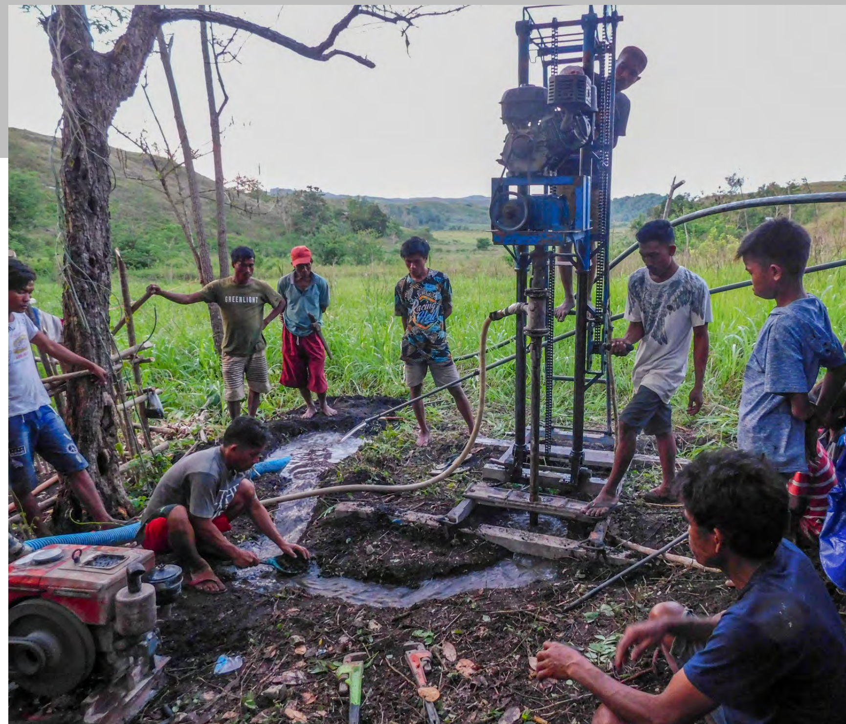
Les premiers puits de forage à Mbinudita a démarré
