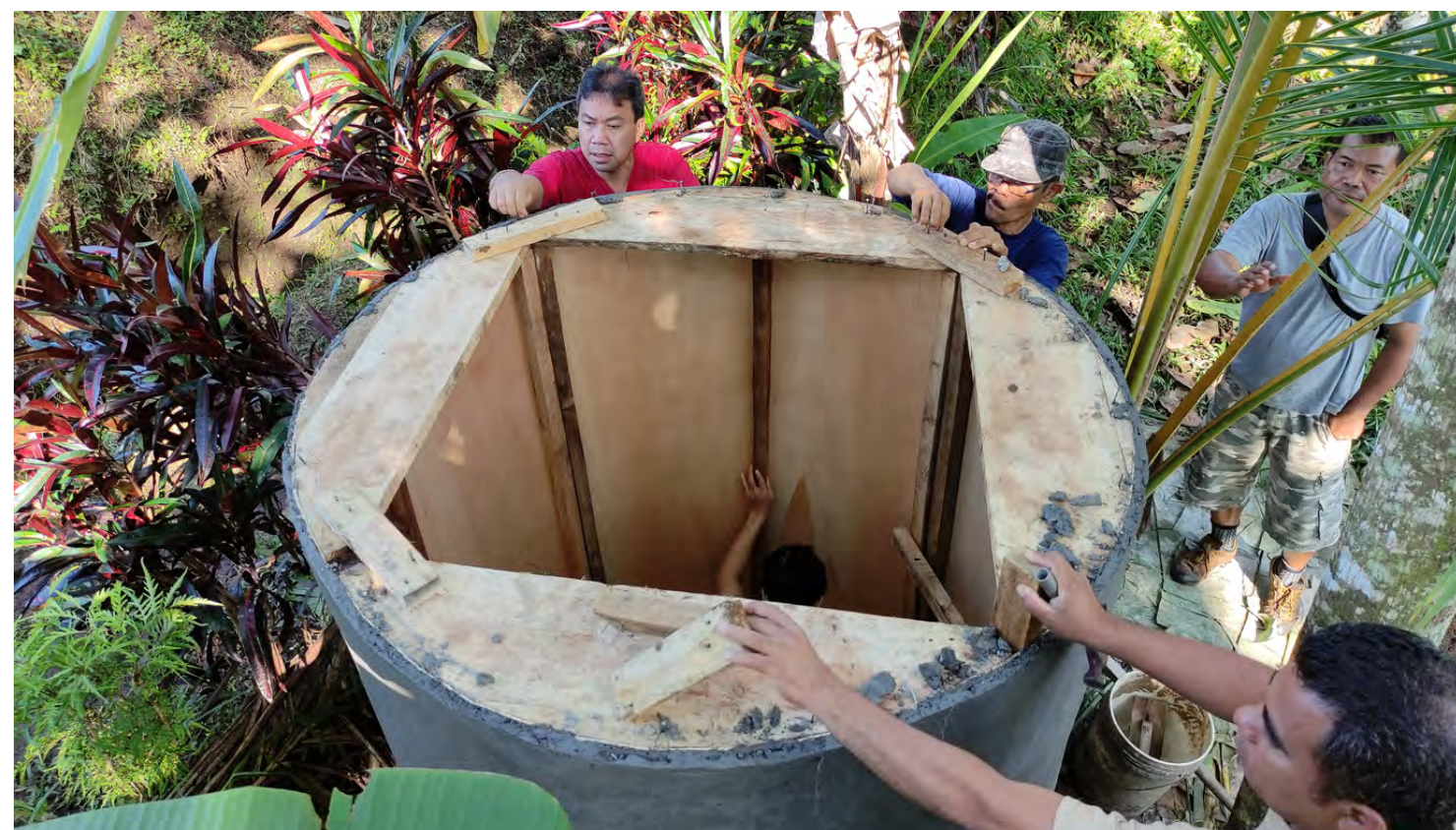
Rencontre avec un villageois de MbinuDita et formation sur le réservoir d'eau en ferrociment
